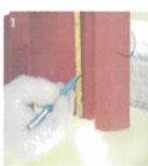
Menentukan titik-titik screw agar tepat pada rangka
