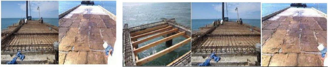
Gambar 26. Lantai Beton
